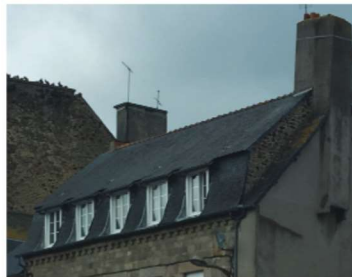
Modification de la toiture 4, 6 rue de Lourmel
