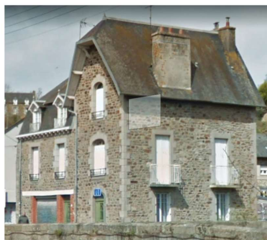
Petit immeuble, 15,17 rue du Bourg Hurel
