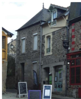
Maisons de ville, 10 et 12 rue du Four
