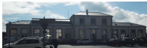
Photo de la gare aujourd'hui après travaux
