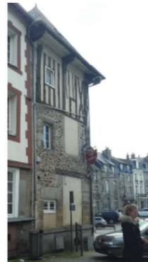
Modification des ouvertures d'une maison à pans de bois et pierre, 2 rue du Four
