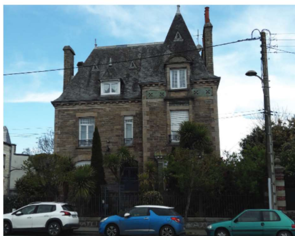
Demeure bourgeoise, pierre (moellons et pierres appareillées) avec émaux, 35 Blvd Jobert
