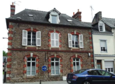
Maison de ville, XIXe siècle, pierre (moellons) et détails en briques Blvd Jobert
