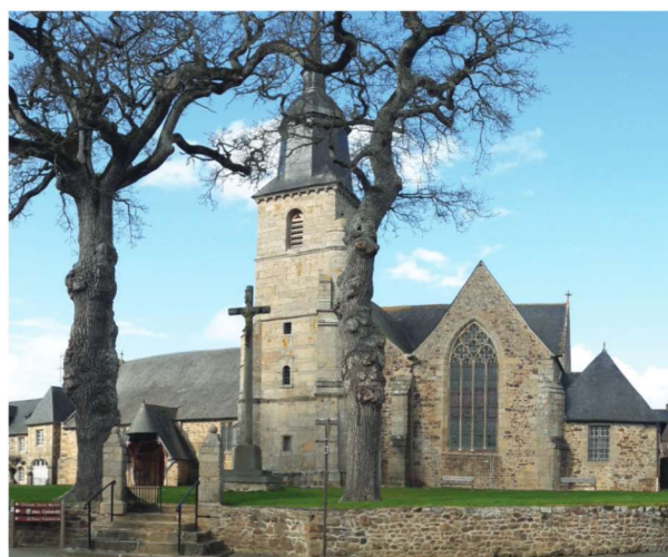
Vue de la façade sud de l'église Saint Martin
