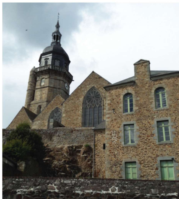
Vue de la façade sud de l'église Saint-Jean
