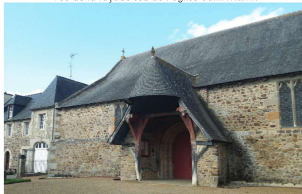
Détail sur le porche de l'église priorale Saint-Martin
