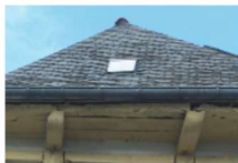
Installation d'un châssis vitré dans la couverture, 11 rue Dr Calmette
