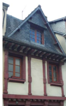
Modification de la toiture, 29 rue Dr Calmette
