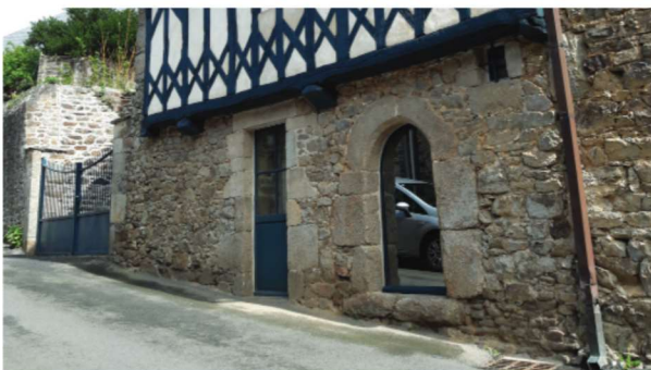
Modification des menuiseries et linteau, rue de la Tour aux Chouettes
