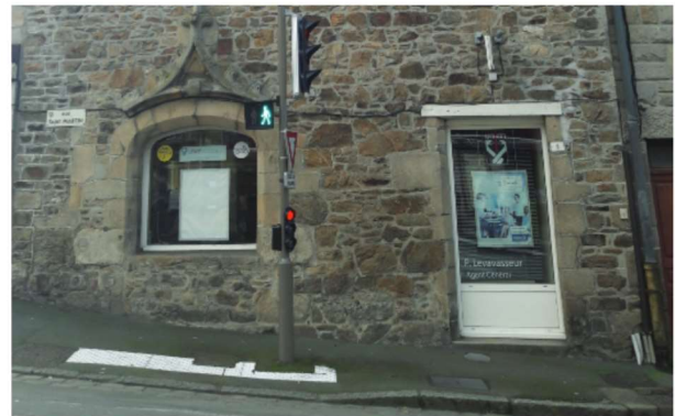
Modification des menuiseries et linteaux, 1 rue Saint-Martin
