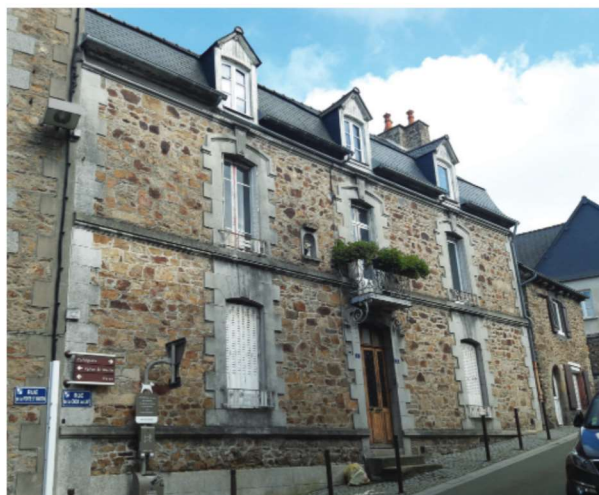
Maison Bourgeoise, pierre (moellons) et pierre appareillée pour les encadrements et bandeaux, 1 et 3 rue de la Croix au lait
