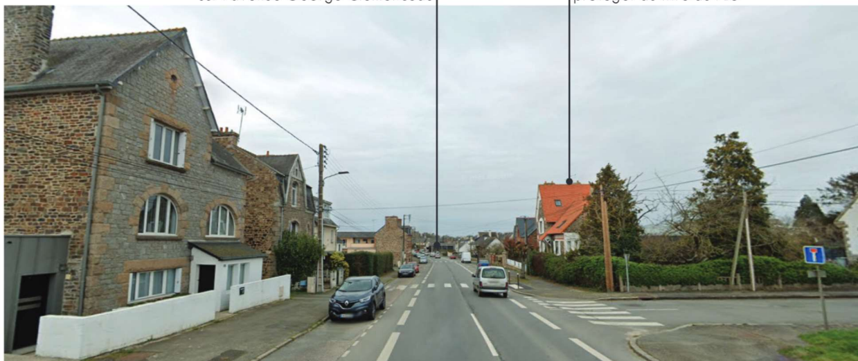
Vue de l'avenue George Clémenceau
