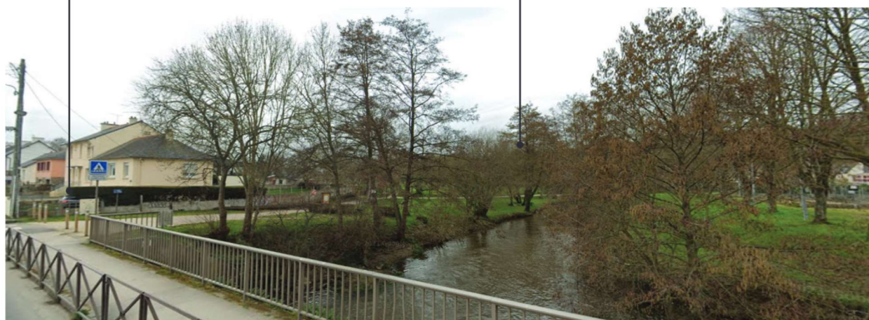
Rue du Maréchal Foch, vue depuis l'ouvrage traversant le Guouessant
