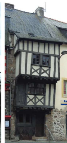
Maison à pans, 6 rue du Four
